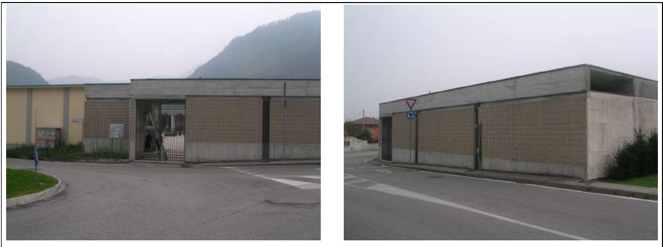
Fotografie dell'intervento realizzato- cimitero di Torrebelvicino (VI)
